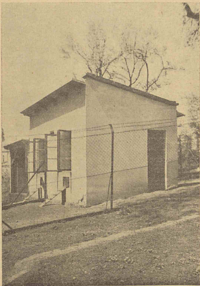
Rycina 5. Kurnik Zakładu Hodowli Zwierząt; z lewej strony widoczne jest kryte grzebalisko.
