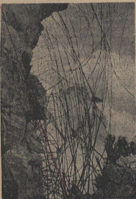
Zburzone skrzydło bunkru Hitlera, w którym mieściła się słynna sala konferencyjna i gdzie rodziły się plany i decyzje podboju i zniszczenia świata.
