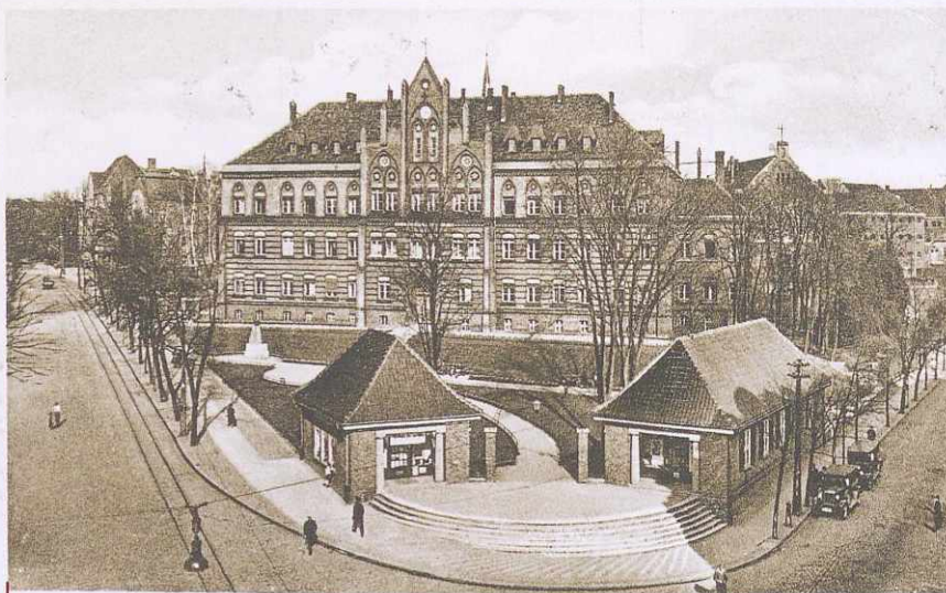
To w tym przedwojennym gmachu w Olsztynie mieścił się w latach 1945-1956 Wojewódzki Urząd Bezpieczeństwa Publicznego. FOT. © ARCHIWUM
