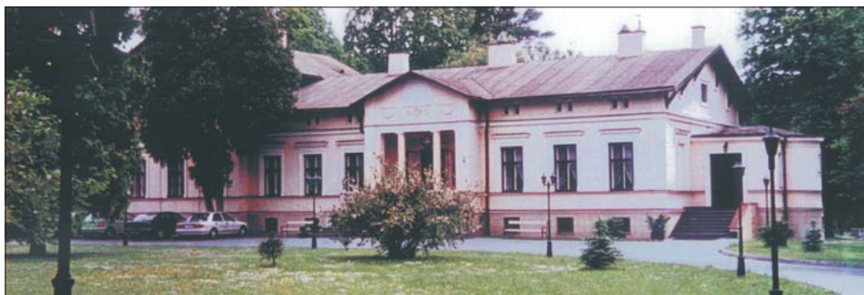
Rys. 2. Budynek dworski od strony elewacji frontowej [Zdeb 2001]
