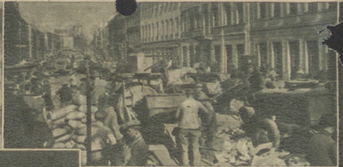
Na Nowym Świecie w Warszawie trwają prace przy wymianie nawierzchni. Ulica ta będzie pierwszą całkowicie odbudowaną arterią stolicy. Większość domów jest już odbudowana. Obecnie trwają przy nich tylko prace tynkarskie
