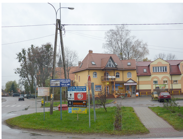
Rys. 9. Centrum handlowo-usługowe w Jonkowie (2013 r.)
