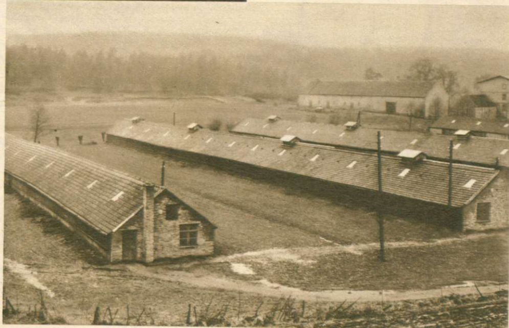
Poniżej: Ogólny widok króliczej farmy, w której 12 ludzi obsługuje 5.000 małych mieszkańców.
