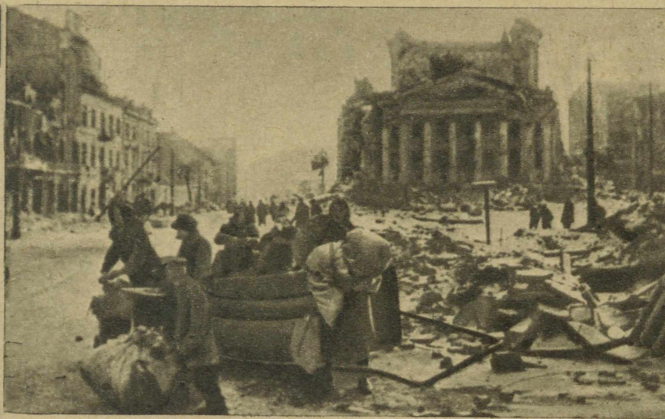
Popatrzcie na plac Trzech Krzyży. Jak ogromne zaszyły tu zmiany w ciągu siedmiu lat! Martwą ruinę wyparły nowe budynki. Wspaniała fasada gmachu PKPG jest ozdobą placu tętniącego nowym życiem. Pośrodku — na miejscu rumowiska — wznosi się zbudowany od nowa kościół.
