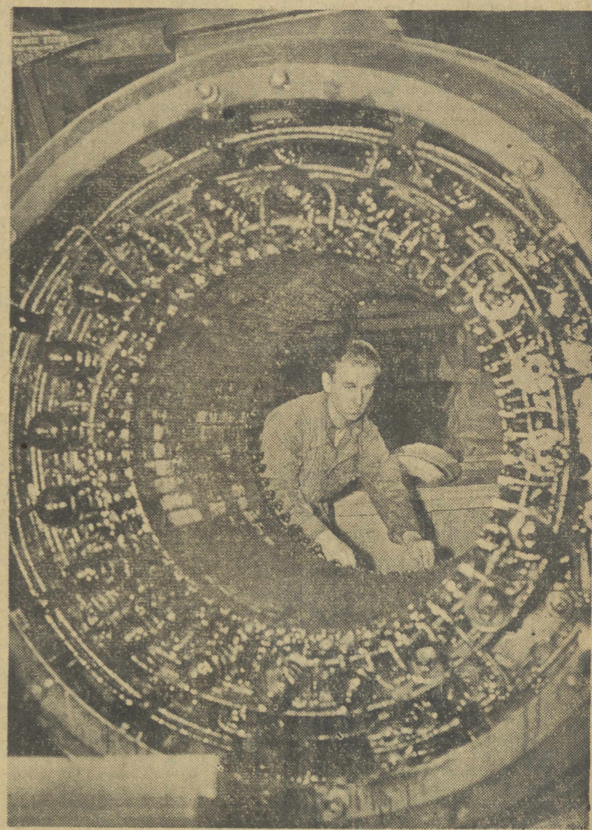
Nawijacz Górnośląskich Zakładów Maszyn Elektrycznych — Jerzy Kieścicki pracuje przy nawijaniu wielkiego generatora. CAF — fot. Kondracki
