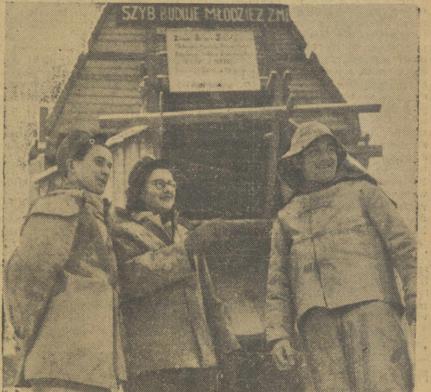
W kilkunastu punktach Warszawy wyrosły już wieże szybów wyciągowych warszawskiego Metro. Jeszcze w tym roku brigady kopaczy rozpoczyna budowę właściwych tuneli, którymi w r. 1955 pomkną pociągi podziemnej kolei.
