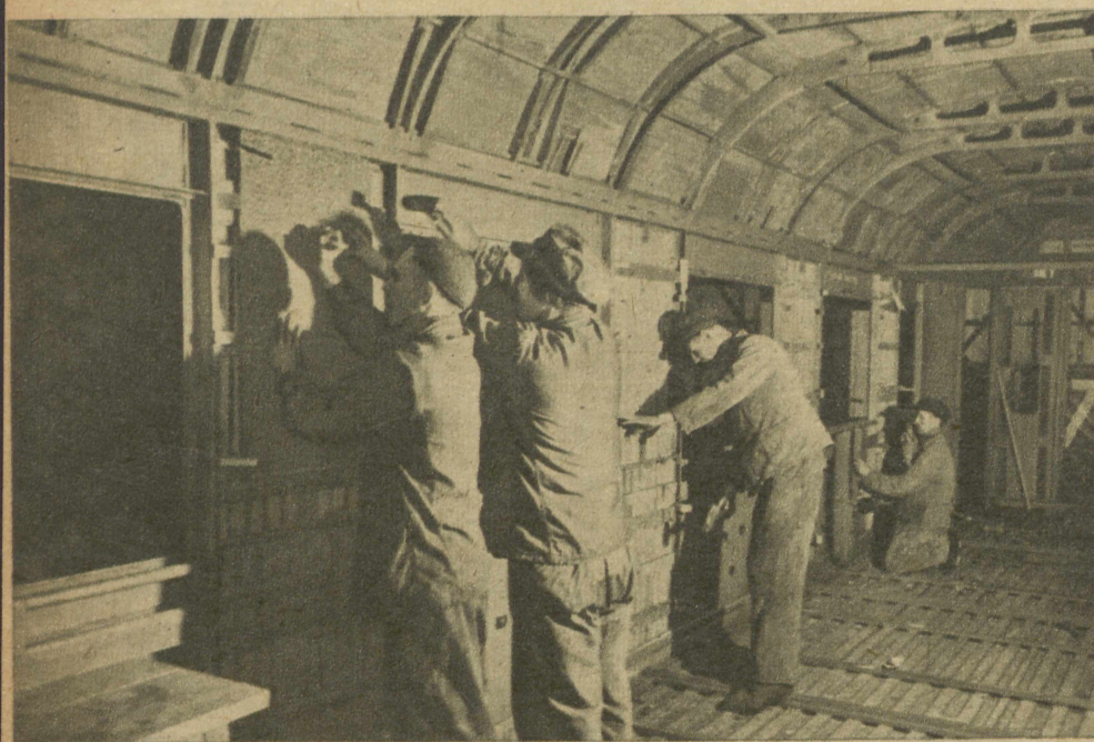
Ze starego Wrocławia potoczą się nowe partie lśniących lakierem wagonów. Zanim zaczną przemierzać stalowe szlaki Polski, przejdą w Państwowej Fabryce Wagonów szereg „kosmetycznych zabiegów”. Brygada stolarska Ignasiaka wykiada właśnie wnętrze wagonu osobowego izolatorom. Trzeba przyznać, że na razie ten wagon w niczym nie przypomina jeszcze zacisznego wnętrza błyszczącego lakierem przedziału. Fot. CAF
