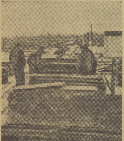
Brigada Pażuchowskiego przy układaniu supejmy na stropie magazynu materiałów budowlanych. Foto Wł. Piotrowski
