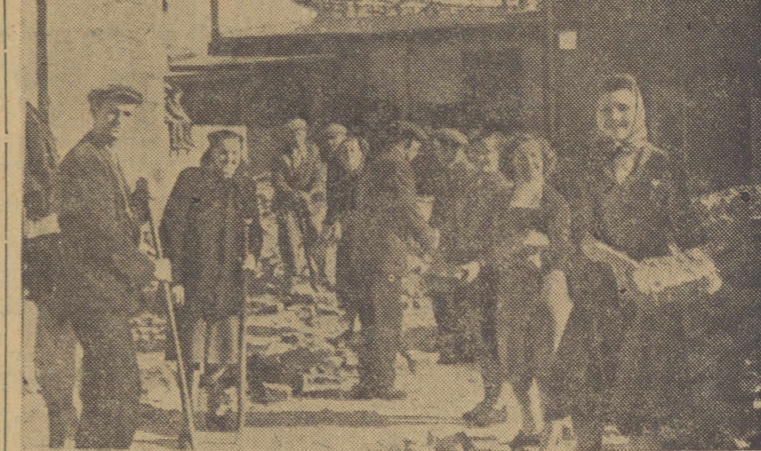
W społecznym czynnie na cześć 1 maja wzięły udział liczne zalogi olsztyńskich zakładów pracy. Jak co roku tak i obecnie wydobły z gruz dziesiątki tysięcy cegieł. Na zdjęciu pracownicy biura PKS realizują zobowiązanie majowe. Fot. K. Adas
