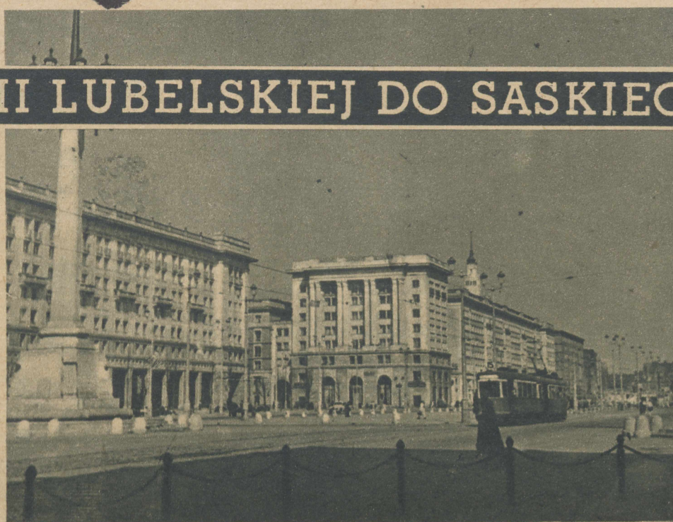
tam jasne, nowoczesne domy z pięknymi, wygodnymi mieszkaniami. Gotów jest od prawie dwóch lat, MDM-owski pl. Konstytucji. Zamiast dawnych, ciemnych i ciasnych podwórek — dziś między blokami Marszałkowskiej Dzielnicy Mieszkanowej ciągną się szerokie dziedzińce.
