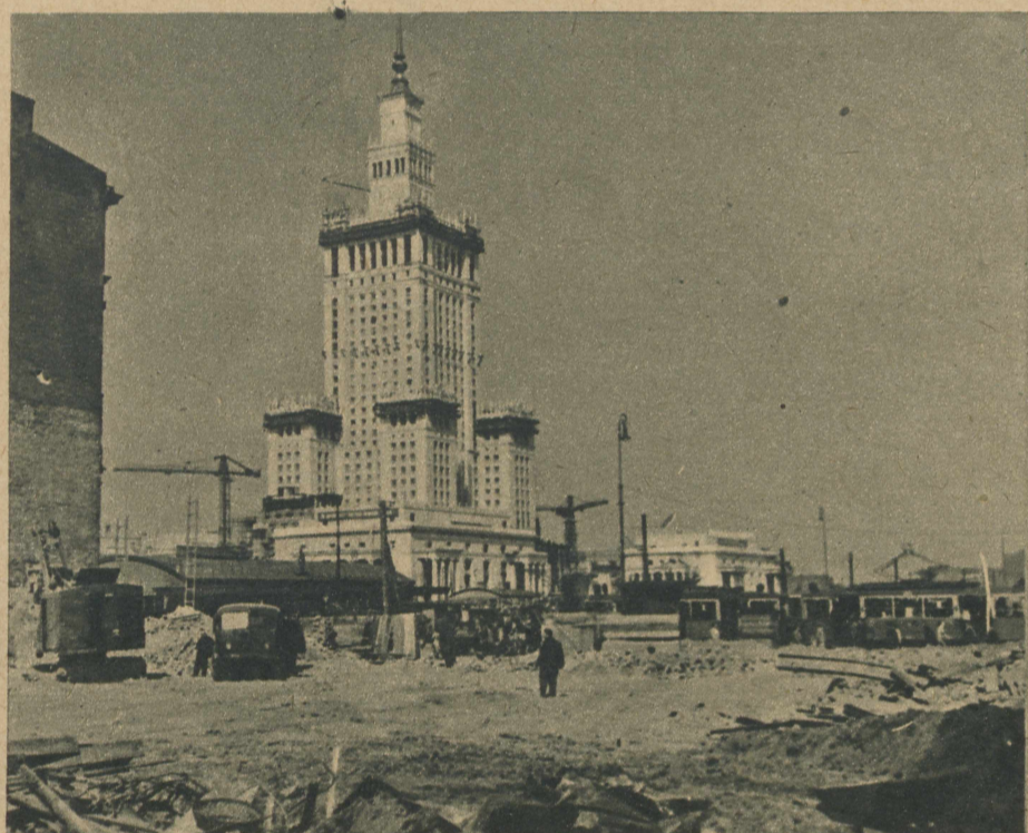
Dziesiątki brygad betoniarzów i brukarskich układają podłoże przyszłej asfaltowej nawierzchni, montuje się nowe torowisko tramwajowe z rozjazdami, przygotowuje się latarnie elektryczne itd. Spychacze i parowe walce wyrównują i niwelują teren. Przy pomocy najnowocześniejszego sprzętu mechanicznego, udostępnionego załodze Miejskiego Przedsiębiorstwa Robót Drogowych przez radzieckich budowniczych Pałacu Kultury i Nauki, prace po-
