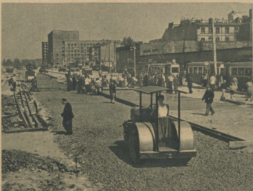
stępują bardzo szybko. Plan robót przy budowie nowej Marszałkowskiej i placu przed Pałacem został już znacznie przekroczony. Jak można sądzić z obecnego zaawansowania prac — już w lipcu br. oddany zostanie do użytku odcinek ul. Marszałkowskiej od al. Jerozolimskich do Ogrodu Saskiego. A w przyszłym roku gotów będzie i centralny plac przy Pałacu i przylegające do niego ulice nowego Centrum Warszawy.
