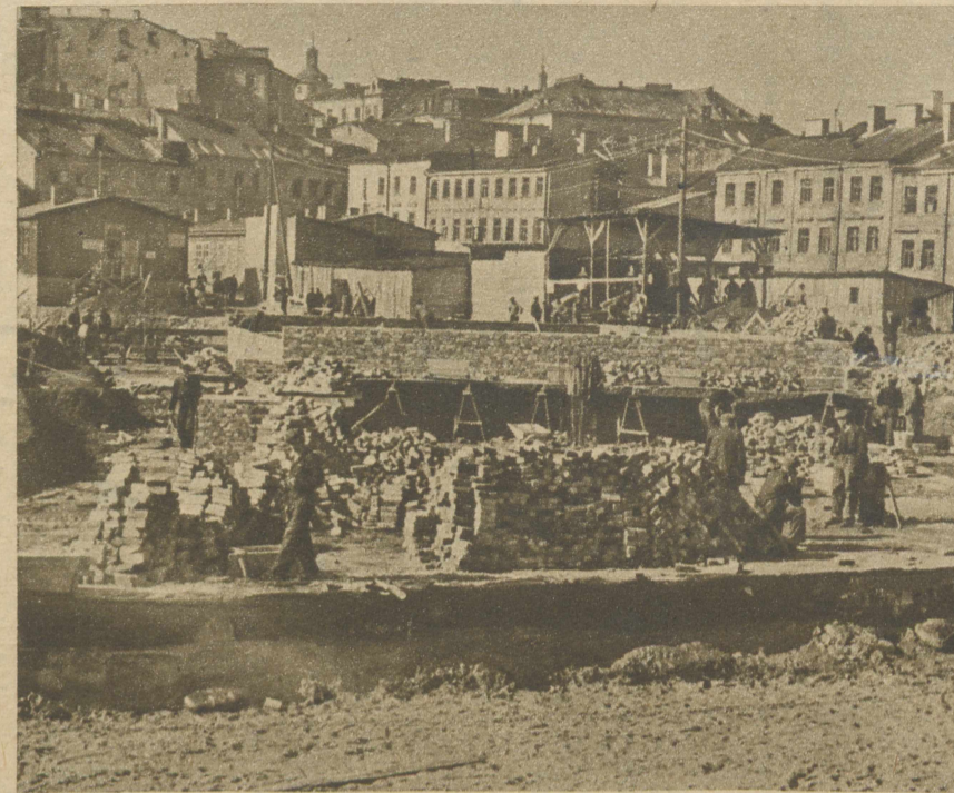
Po północnej stronie skarpy zamkowej wre praca przy budowie lubelskiego Mariensztatu, nowej dzielnicy mieszkaniowej o zabytkowej, nawiązującej do historycznych tradycji architekturze. Do 22 lipca osiedle ma być gotowe w stanie surowym.
