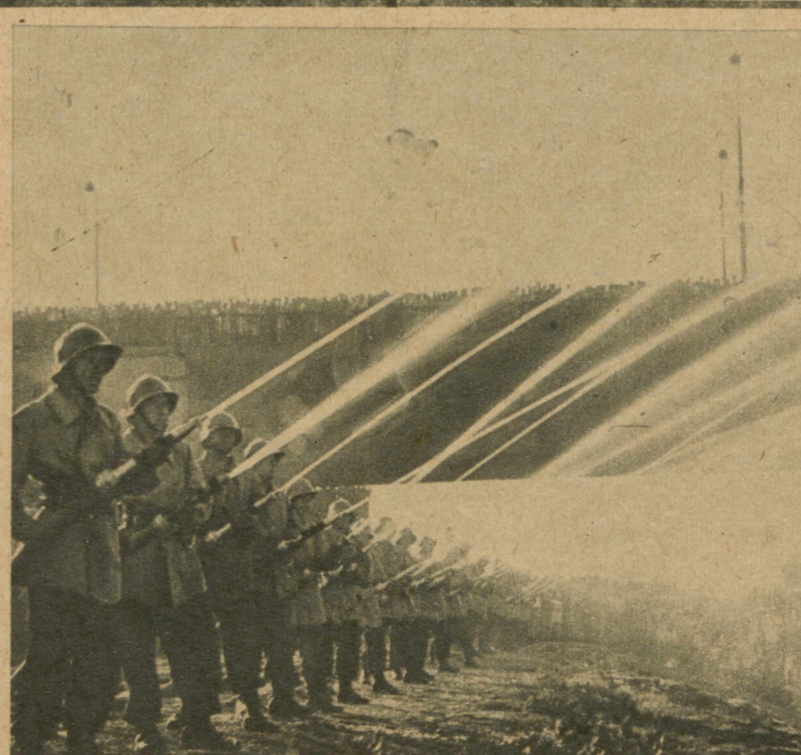
Taka „ściana wodna” zdolna jest ugasić nawet poważny pożar. Mogliśmy obserwować jej działanie w czasie pokazu. Fot. E. Romanowski
