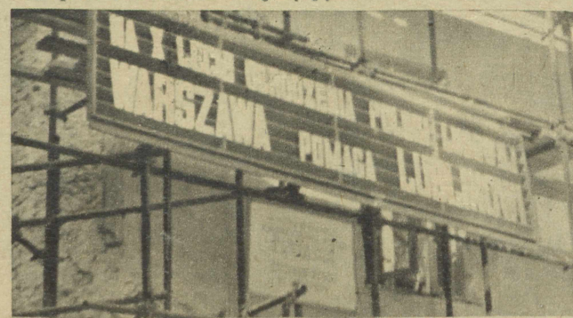
Najlepsze ekipy z Warszawy (patrz zdjęcie) i Szczecina, pomagają lubliniakom w przebudowie miasta. Doświadczeni budowniczowie warszawskiej Starówki pozostawiają Lublinowi trwałą pamiątkę swej pracy.
