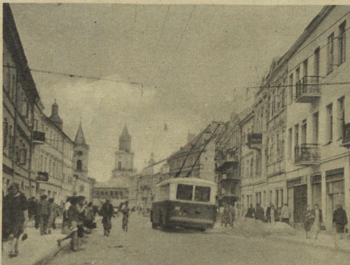
Na Krakowskim Przedmieściu przechodnie „wrócili” już na chodniki, do niedawna zawalone belkami, deskami, sprzętem... Piękna centralnej ulicy Lublina nie będą już szpecić odrapane domy. Wieczorami zajaśnieją tu neony.
