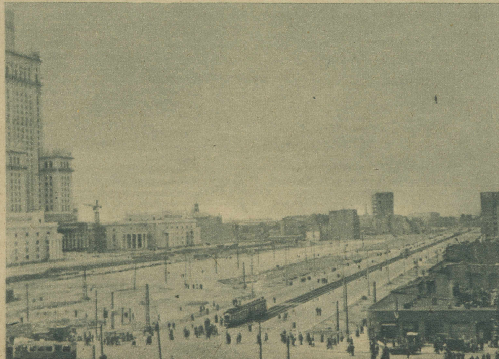
Znikł wreszcie „korek” w centrum Warszawy. Odetchnęli z ulgą motorniczowie tramwajów i kierowcy samochodów. Poszerzona i przebudowana Marszałkowska od Al. Jerozolimskich do Królewskiej jest pierwszym oddanym do użytku fragmentem nowego śródmieścia.
