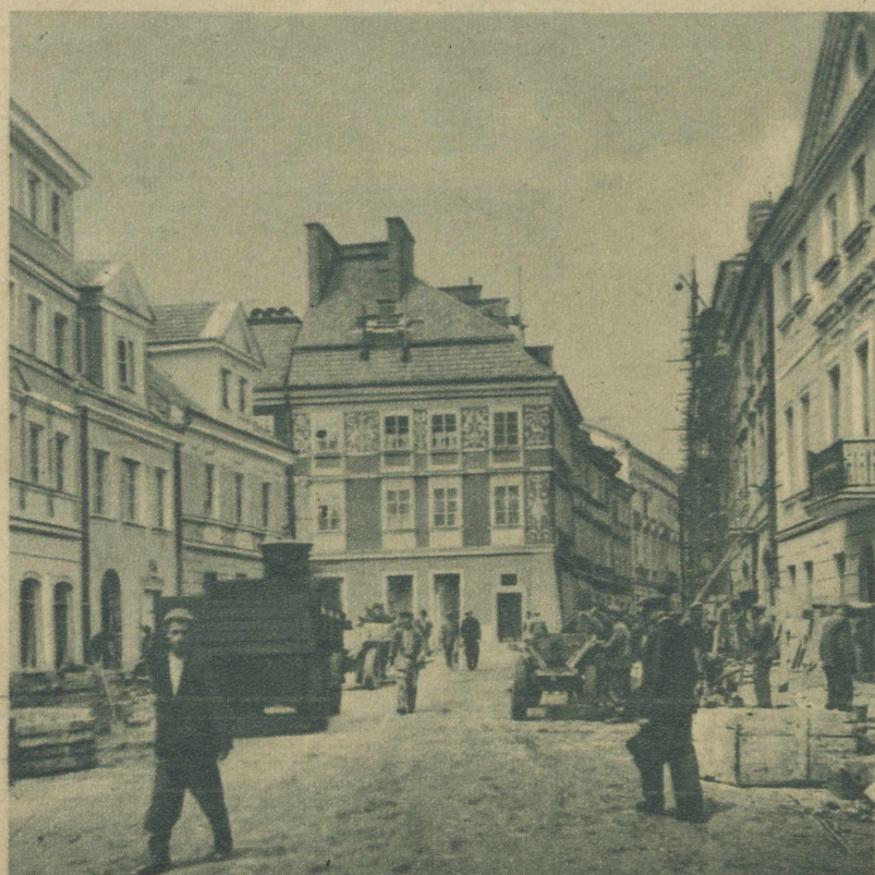
Druga część staromiejskiego Traktu jest już przekazana do użytku. Do kamieniczek przy Freta, Zakroczymskiej, Podwału, Nowomiejskiej i Mostowej wprowadzili się lokatorzy. Trwają teraz prace przy dalszych partiach Starego i Nowego Miasta.
