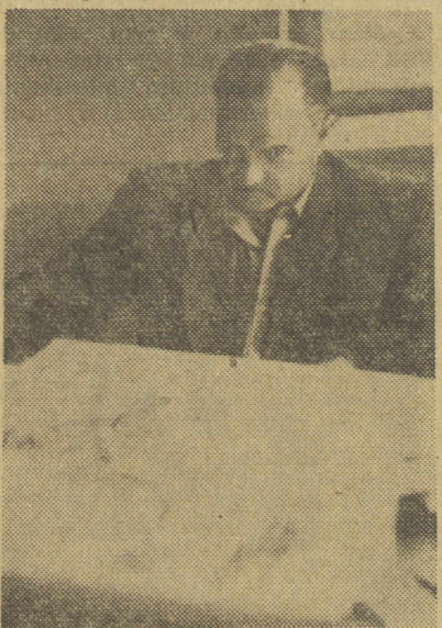
lnż. Kwapiszewski inicjator i kierownik budowy kanału Wieprz-Krzna (fot. r.l.)
