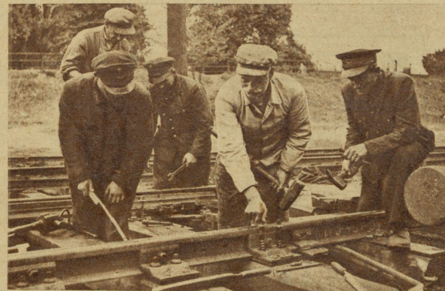
Konieczność dość częstej wymiany podkładów na torach przyczyniała masę kłopotu „drogowcom”. Przed swym świętem najlepsza brigada odcinka drogowego w Gdańsku-Oliwie, stosując radzieckie metody, przystąpiła do nasycania podkładów środkami grzybobójczymi. O 3 do 5 lat przedłuży to trwałość podkładów. Oto członkowie przodującej brygady przy pracy.
