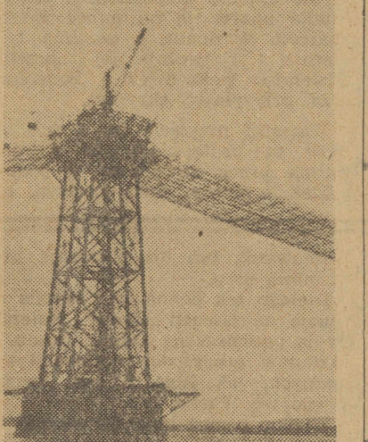
Z betonowej wyspyk wznosi się wieża — opora powietrznego mostu przez Wołgę.
