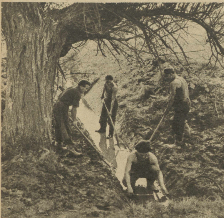
80 ha zmeliorowanych gruntów ornych zyska spółdzielnia produkcyjna w Łęcznie pow. Białogard. Ponad 4 tys. m. rowów melioracyjnych trzeba było wykopać, aby odwodnić ten duży obszar spółdzielczych pól. Obecnie prace już zakończono — zdjęcie niniejsze przedstawia ich ostatnie fragmenty.
