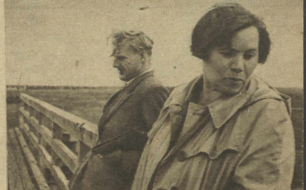
Na drewnianym mostku spotkał się pracownik grup mierniczej z inspektorką Centr. Zarz. Przemysłu Torfowego, Węgrzecką. Plany przechodzą z ręki do ręki. Od jutra zaczynamy budowę wytwórni brykiety! Foto J. Kasprzyk
