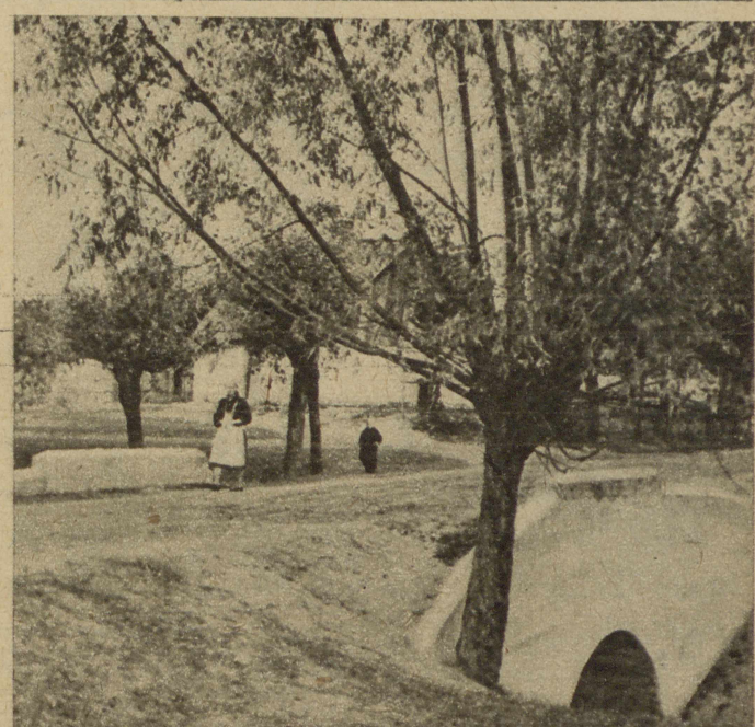
Uzupełnią tę listę osiągnięć gminy Łąck trzy betonowe mostki wybudowane przez mieszkańców. Oto jeden z nich — niewielki, ale solidny — przedmiot dumy wsi Załdierz, będącej jeszcze do niedawna właśnie jedną z „dziur zabitych deskami”.
