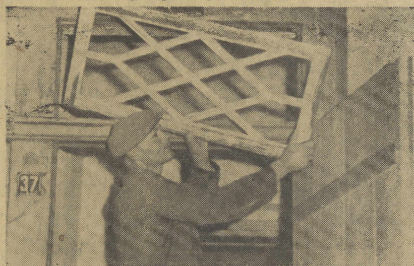
Chłopi z pow. Pasiek (woj. olsztyńskie) przygotowują budynki pod przyszłe siedziby Gromadzkich Rad Narodowych. Na zdjęciu: Jan Cichoński z gromady Kwietniewo pomaga przy remoncie budynku przeznaczonego na siedzibę Gromadzkiej Rady Narodowej. CAF — fot. Zmitowicz
