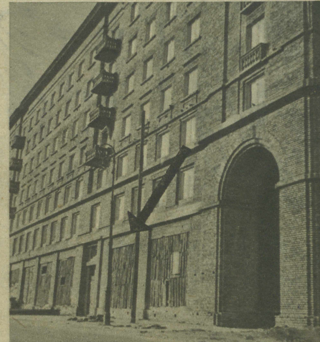
Program wyborczy nie zapominał i o aptekach. Nowa, obszerna apteka przy ul. Elektoralnej będzie się mieścić w bloku 30 (na zdjęciu) i rozładuje choć częściowo tłok w innych — niestety niezbyt licznych — aptekach tej dzielnicy.
