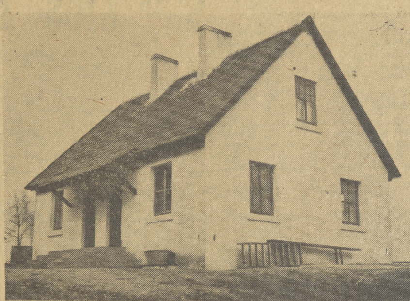
W trosce o sprawy bytowe swoich pracowników dyrekcja PGR Olszaj (pow. Kętrzyń) rozpoczęła budowę nowych domków mieszkalnych. Jeden z takich domków przedstawia nasze zdjęcie (II)
