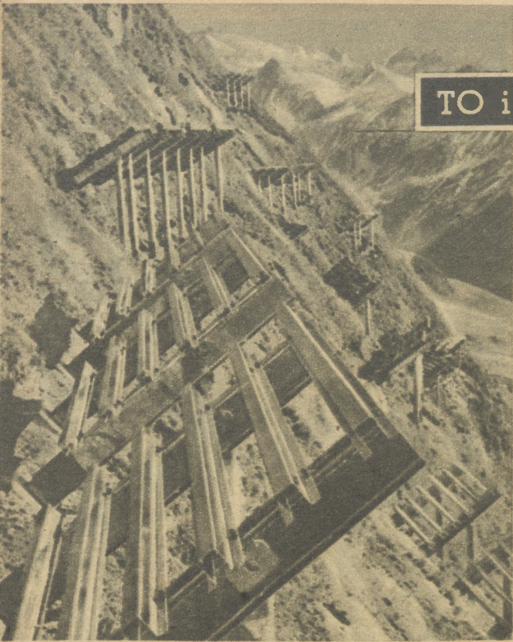
Taka oto zapora ustawili Szwajcarzy na spadziwych zboczach koło Alrolo. Jest ona sporządzona z aluminium i ma hamować impet częstych i gwałtownych w tych okolicach lawin śnieżnych.
