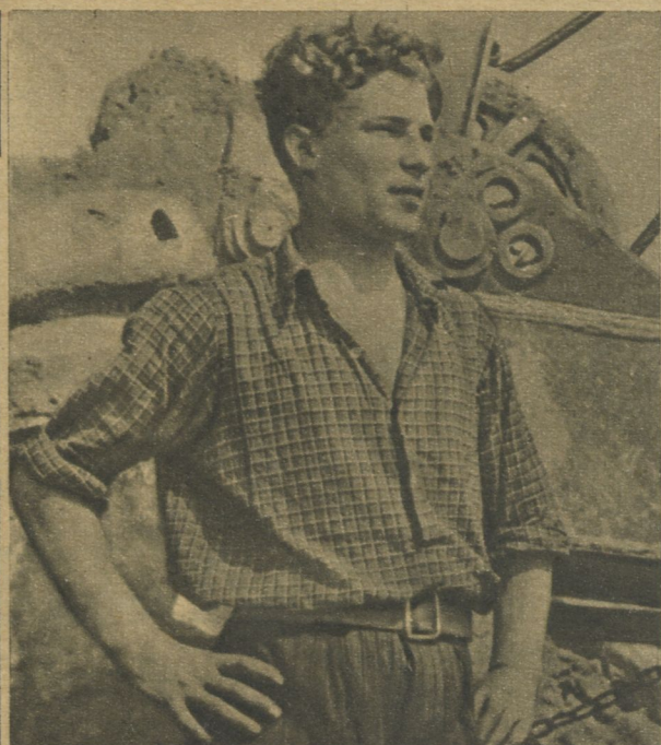
Budowniczowie „Wierzbicy” dokonali wielkiego dzie- ła. Dzięki wytrwałej i pełnej poświęcenia pracy oddają do użytku wspaniały, nowoczesny obiekt. Oto jeden z wierzbickich bohaterów pracy — M. Rogusz, opera- tor koparki, wykonujący 300 proc. normy. Fot. Włodarkiewicz
