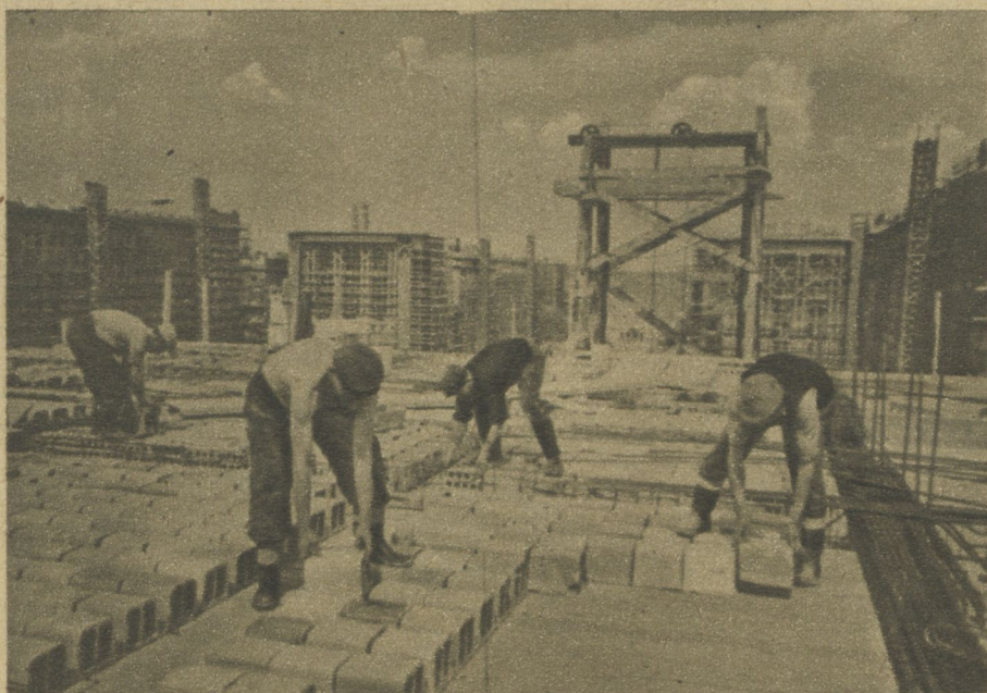
Już tylko niecałe 2 miesiące dzielą nas od otwarcia głównego placu Marszałkowskiej Dzielnicy Mieszkaniowej. 22 lipca zostanie oddane do użytku to nowe wspólnie osiedle nowej, socjalistycznej Warszawy. Na MDM-ie trwają intensywne prace. Na zdjęciu: brygada Stefańskiego przy pracy na jednym z bloków MDM.
