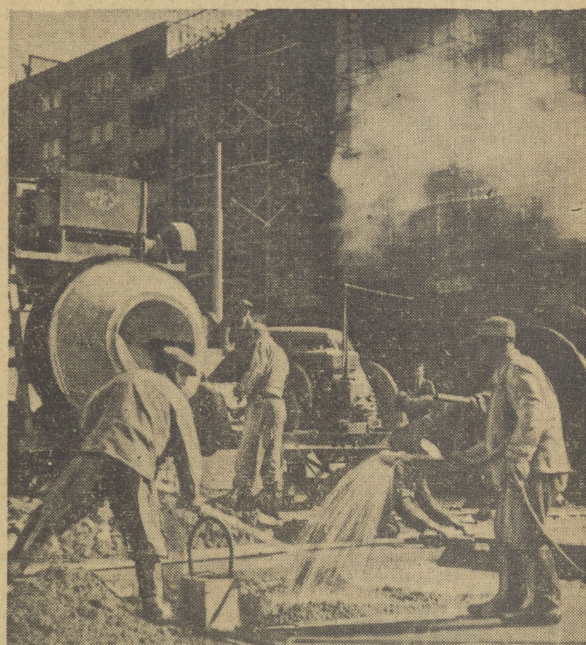
Do terminu oddania Głównego Placu MDM pozostały już tylko 33 dni pracy! Robotnicy budowlani kończą już realizację swoich zadań. Drogowcy również wykonali dużą część prac. Cały niemal Plac pokryty jest asfaltem. Jutro gotowa będzie kolorowa, kamienna mozaika na środku Placu. Na zdjęciu fragment robót drogowych na Głównym Placu MDM. Foto — Ed. Hartwig.
