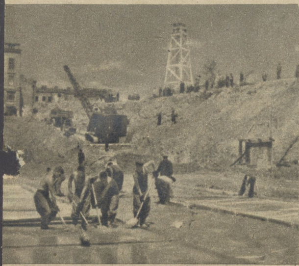
Prace budowy Pałacu Kultury i Nauki zakończono już wy- część wysokościową. Radzieccy robotnicy — S. Zalew- ianoj, J. Kaługin i A. Pożyczniak betonują właśnie krótce pokryje je warstwa izolacji, a potem zaczną się nie ław fundamentowych pod wysokościową część Pałacu.
