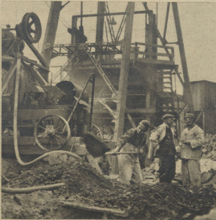
Szyb S-8, to jeden z „najstarszych“ szybów zejściowych war- szawskiego Metro. Budowę jego rozpoczęto w zeszłym roku — pod koniec roku bieżącego będzie on całkowicie gotów. Z szybu, z dołu na wierzch, specjalnymi wielkimi kubłami wydobywa się urobioną ziemię. A przed zejściem do pracy, dobrze jest raz je- szcze omówić program robót, wyznaczonych na dany dzień.
