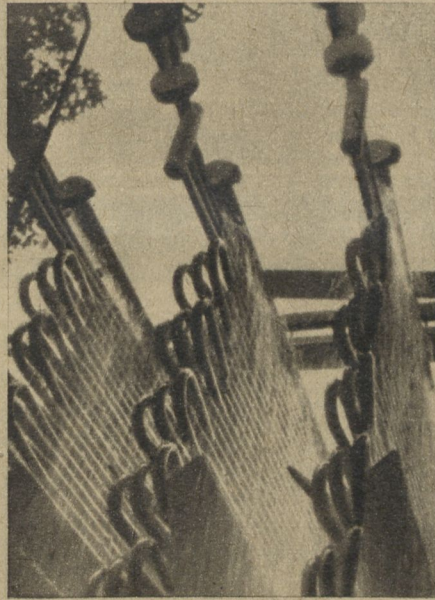
Bez przerwy przepływa woda z róż- nymi składnikami chemicznymi przez aparaturę mrozeniową na szybie S-3. Dzięki tej aparaturze płynna kurzaw- ka zamienia się pod działaniem mro- zu w jednolitą lodową bryłę.
