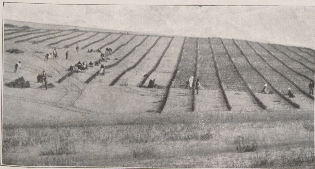
Befestigung der Wanderdünen durch Bepflanzung mit Kiefern.
