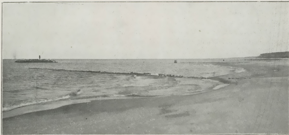
Seebuhnen an der Nehrung bei der Cranzer Plantage. Links das Wrack eines gestrandeten Schiffes.
