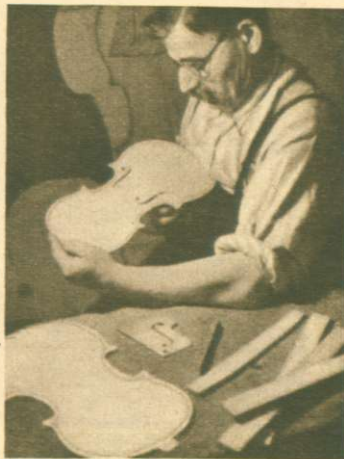
Poszczególne fazy budowy skrzypiec (od lewej): Wycinanie otworów rezonansowych w kształcie litery f. — Przytwierdzanie boków, które połączą górną i dolną płytę skrzypiec. — Wprawianie szyjki. — Sprawdzanie menzury skrzypiec. (Zdjęcia z „francuskiej Cremony” — Mirecourt).
