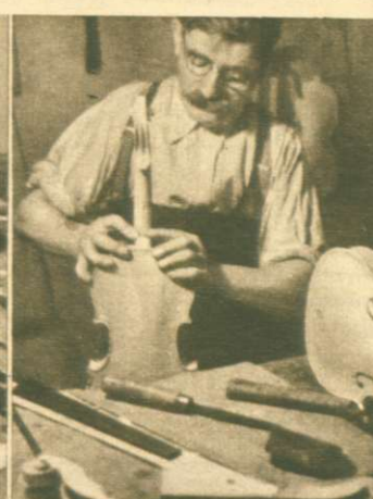
Poszczególne fazy budowy skrzypiec (od lewej): Wycinanie otworów rezonansowych w kształcie litery f. — Przytwierdzanie boków, które połączą górną i dolną płytę skrzypiec. — Wprawianie szyjki. — Sprawdzanie menzury skrzypiec. (Zdjęcia z „francuskiej Cremony” — Mirecourt).
