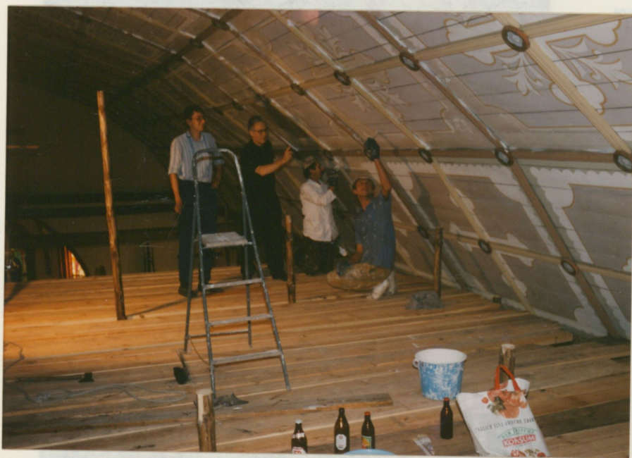
Malowanie sufitu kościół 15 - 18 m. wys.
