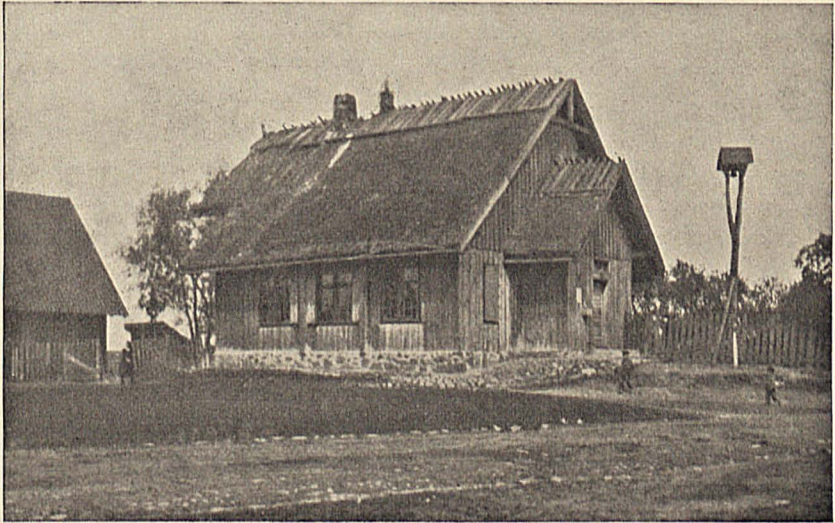
Abb. 36. Alte Schule in Leynau (Kr. Ortelsburg) mit freistehendem Schulglocken-Gehäuse.
