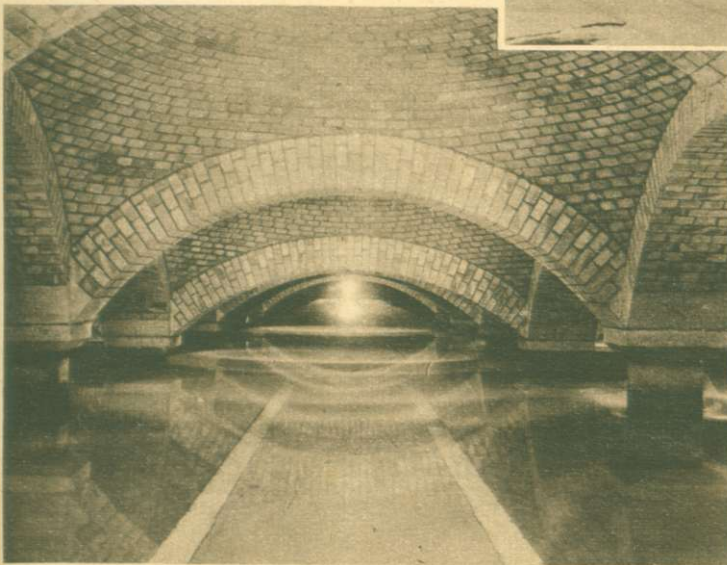
Hala filtrów powolnych.
