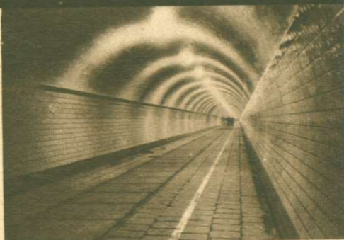
Fragment tunelu długości 500 metrów, ciągnącego się pod Skaldą.
