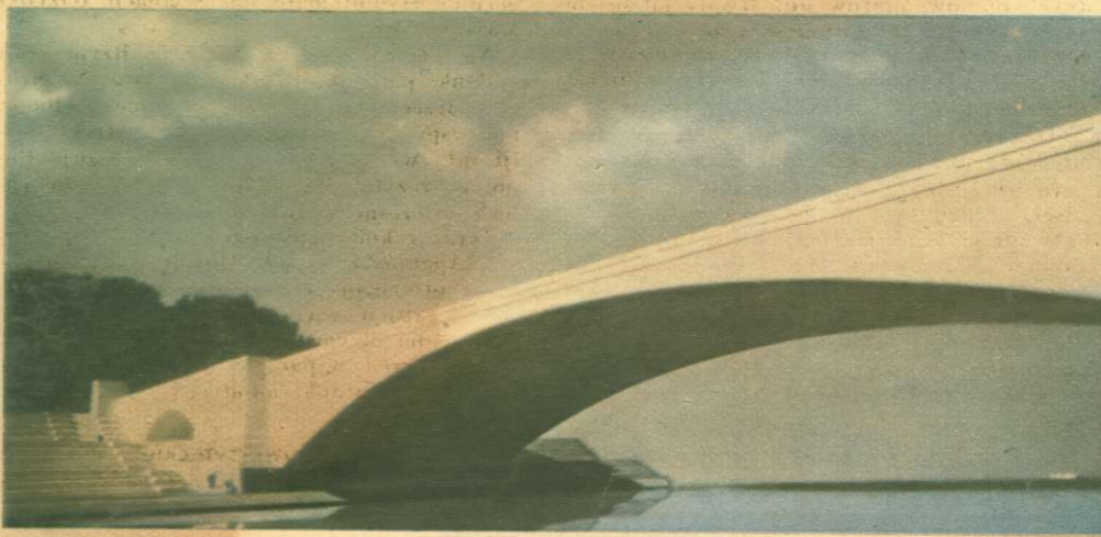
Powyżej: Most o długości 220 m. stanowiąc będzie jedną z najwspanialszych budowli nowego Rzymu.
