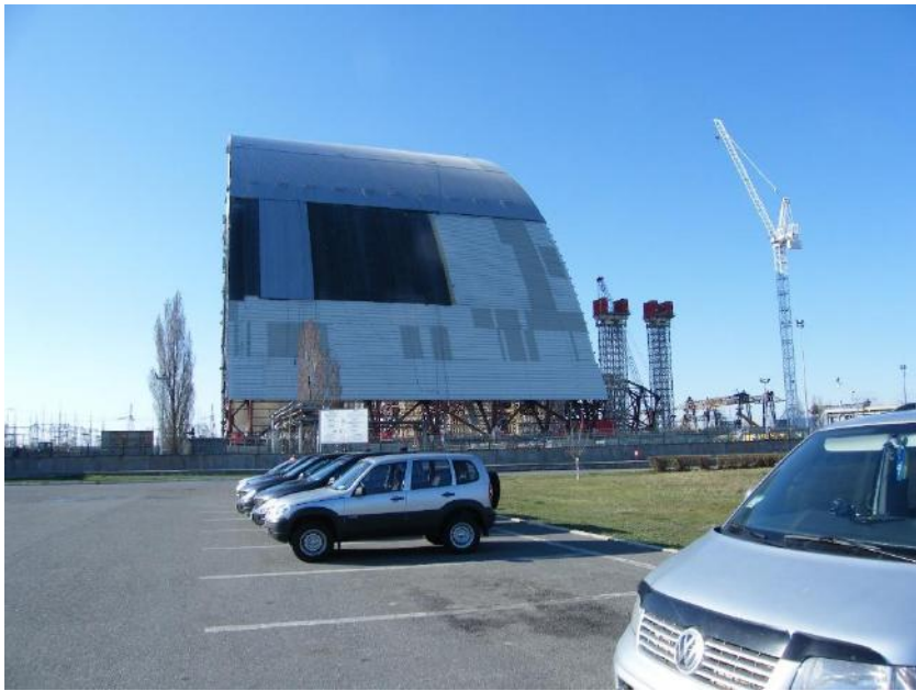
Wschodnia połówka zewnętrznej powłoki Arki w trakcie prac wykończeniowych; kwiecień 2014 roku. (Fotografia M. Rabiński)
