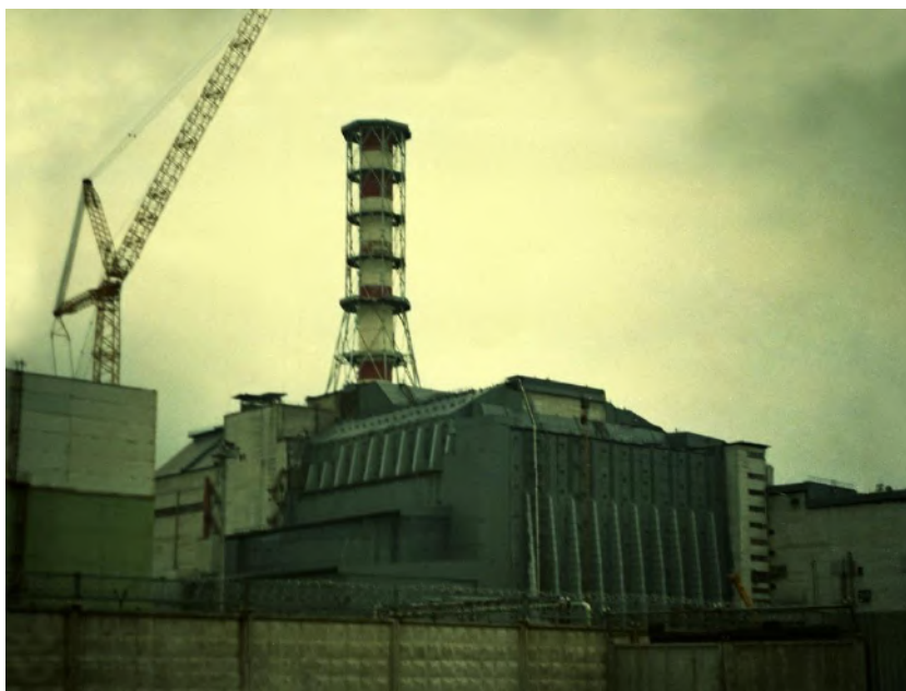
Widok Sarkofagu nad zniszczonym reaktorem nr 4; marzec 1995 roku. (Fotografia M. Rabiński)
