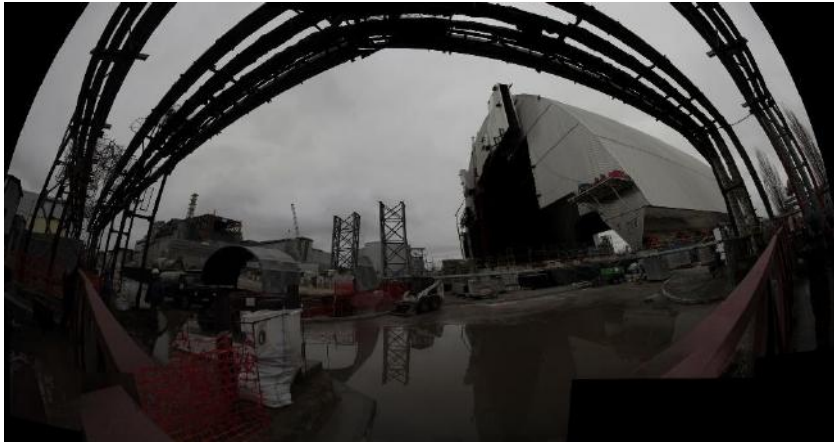
Hala Arkady (po prawej) na dwa dni przed rozpoczęciem operacji nasuwania na stary Sarkofag (po lewej); listopad 2016 roku. (Fotografia M. Rabiński)
