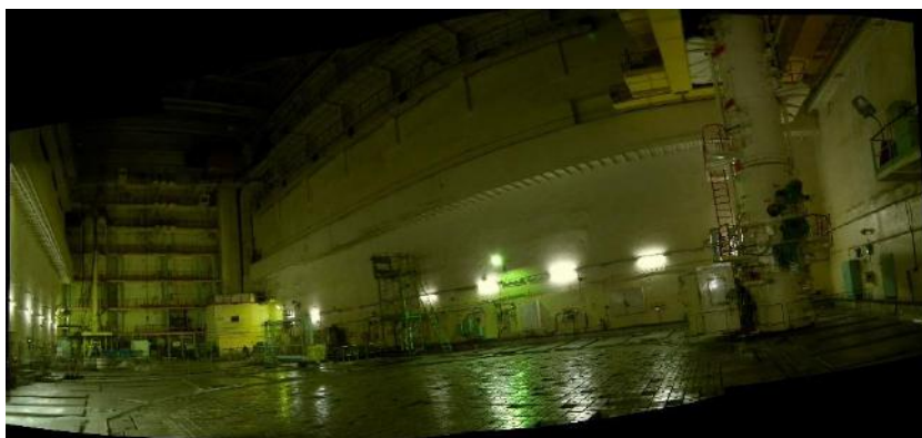
Hala reaktora nr 3 Elektrowni Jądrowej w Czarnobylu; w głębi za ścianą Sarkofag reaktora nr 4, na pierwszym planie – górna płyta reaktora, po prawej – maszyna do przeladunku paliwa. (Fotografia M. Rabiński)
