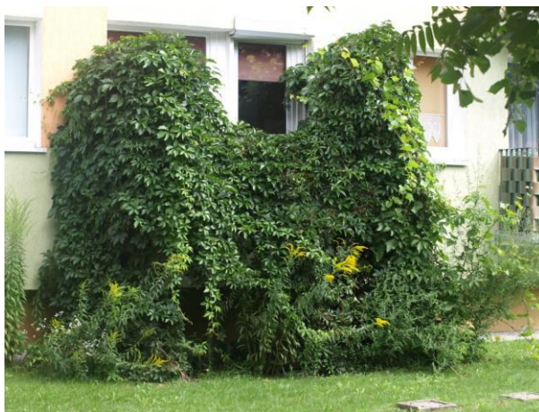
Rys. 3. Widoczne do połowy wysokości okien opuszczone rolety (fot. archiwum autora).
