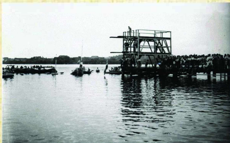
7 Wieża do skoków, ok. 1950-55 r.
