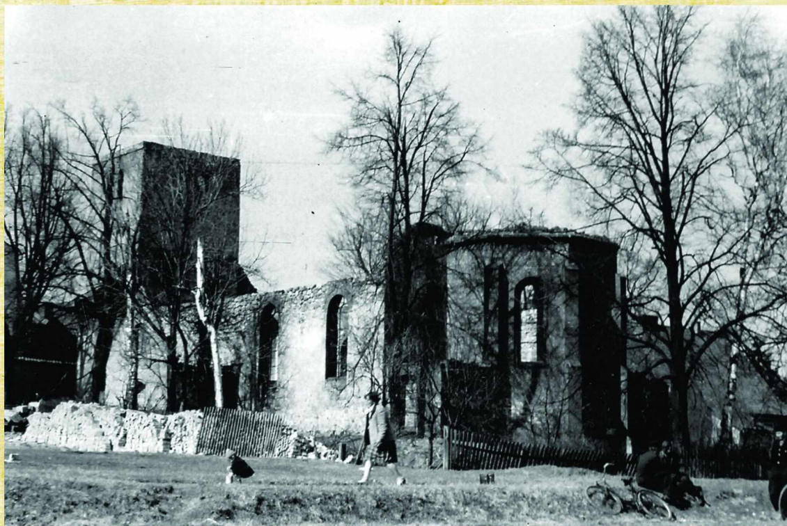
108 Zniszczenia wojenne, dobrze widoczne zaokrąglone zwieńczenia okien, które przy odbudowie zmieniono na ostry łuk
