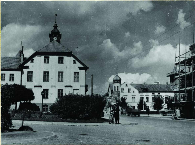
[135] Po prawej budowa budynku ze sklepem „1001 drobiazów”
