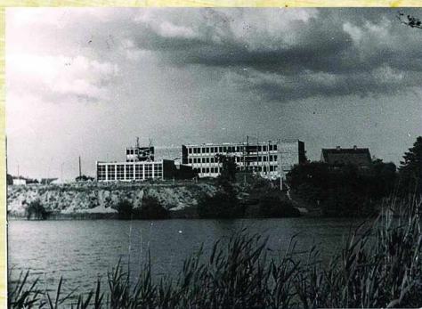
52 Budowa Szkoły Zawodowej powyżej j. Sołtyckiego, 1966 - 67 r.
