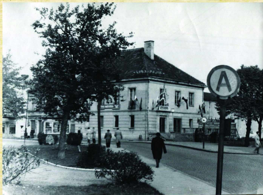
182 Kino Mazur, po lewej brak współczesnych pawilonów handlowych, ok. 1970 r.
