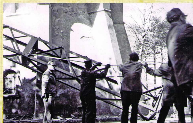
249 Montaż masztu radiowo-telewizyjnego na wieży Bismarcka, rok 1966 (?)
