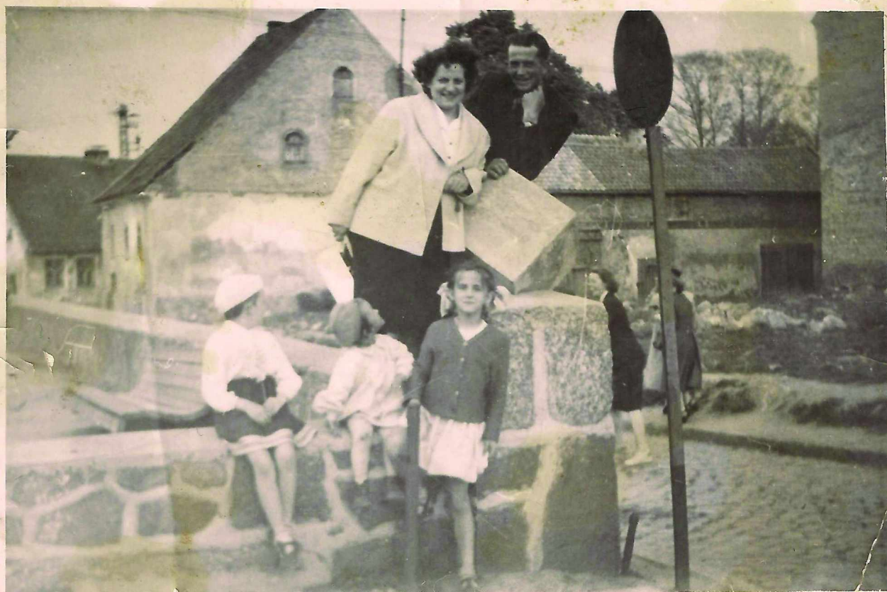
[83] Po lewej w głębi budynek jednorodzinny przy ul. Roosevelta. Obecnie w tym miejscu restauracja. Po prawej puste miejsce przed budową budynku 1001 drobiazgów, lata 60-te
