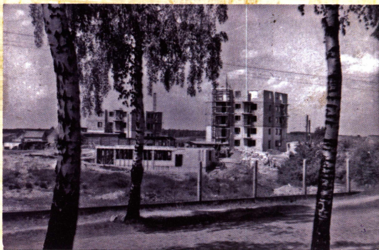
262 Budowa osiedla, lata 60-te
