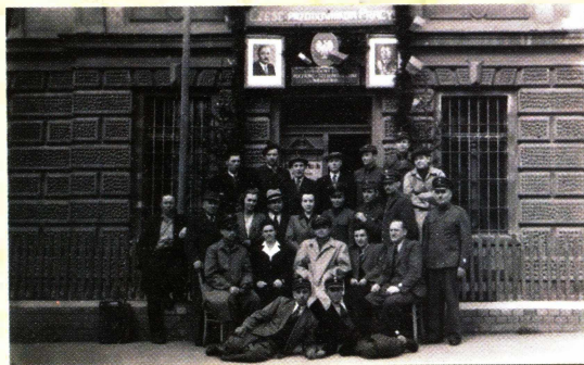
28 Obwodowy Urząd Pocztowno-Telekomunikacyjny. Po prawej na krześle A. Kotelon, 1.05.1948 lub 1949 r.
