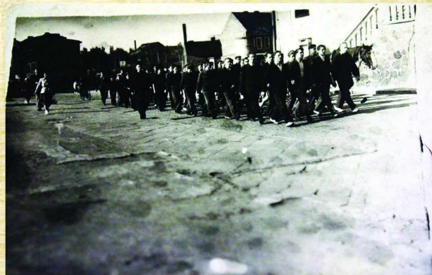
[80] W oddali zniszczony hotel Masovia, w głębi w górnej części szkoła LO, 1954 r.
