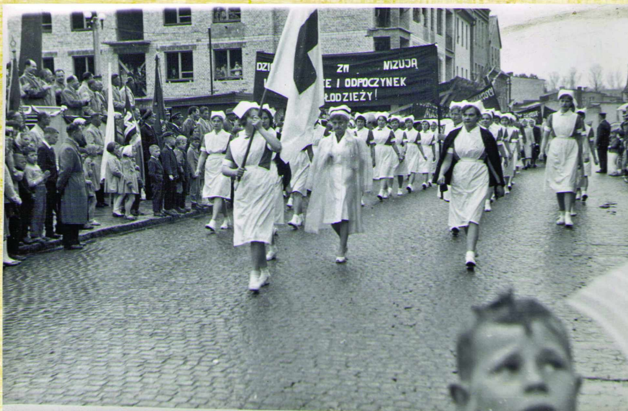
[82] W tle budowa budynku 1001 drobiazgów, 1962 r. (?)
