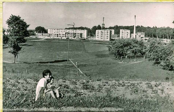
260 Budowa os. Brzozowego, w tle wieża Bismarcka z nadajnikiem radiowo-telewizyjnym
