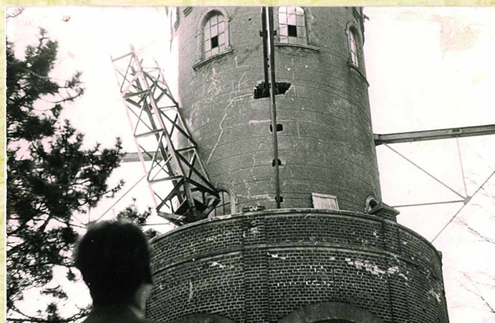
248 Montaż masztu radiowo-telewizyjnego na wieży Bismarcka, rok 1966 (?)
