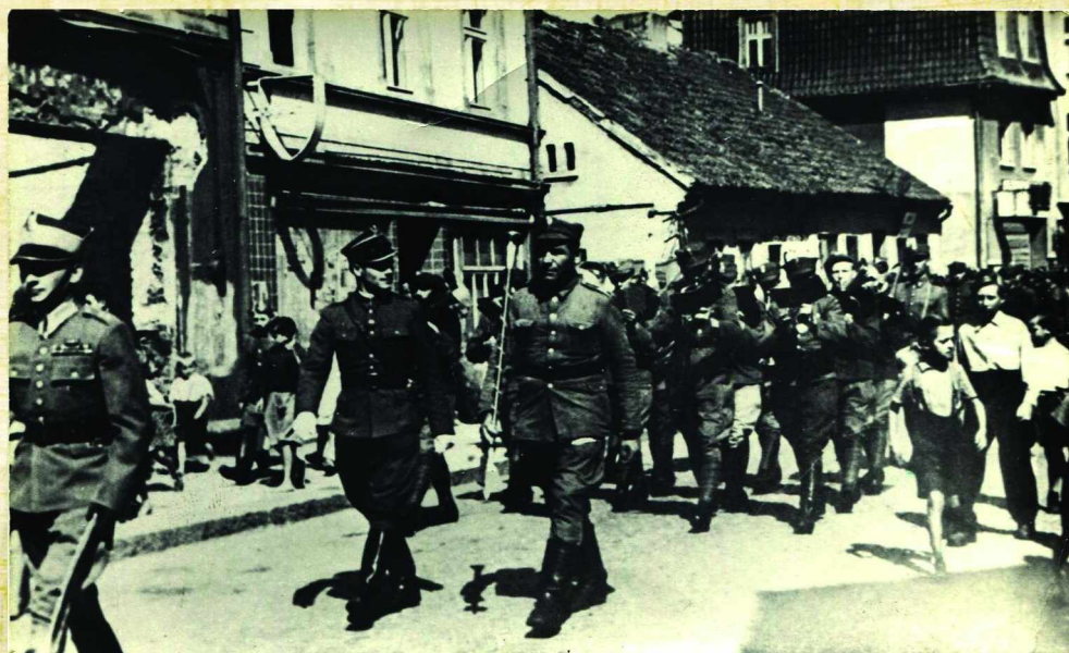
[172] 54 pułk piechoty WP, budynki wyburzone w miejscu obecnego placu przy j. Magistrackim, 21.05.1946 r.
