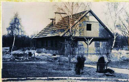
117 W trakcie budowy
