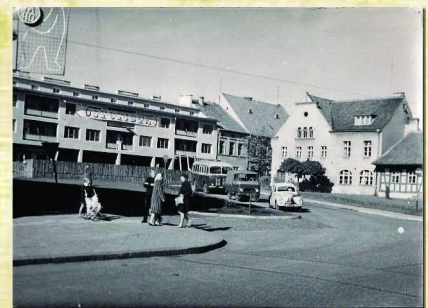
128 Budowa budynku z restauracją „Fregata”, po lewej neon „Miś”, lata 60-te
