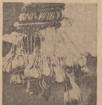
Oto ładunek balonu papierowego: balast – worki z piaskiem i bomby burzowe.
