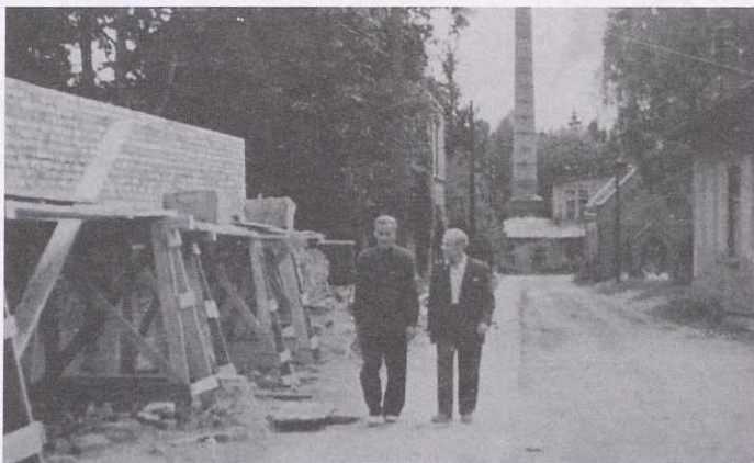
Ryc. 7 Projektanci na placu budowy: Zbigniew Borowik (konstruktor) i Edward Mjchalski (architekt). Obok z lewej: budowa bl. 38 a w głębi: bl. 14, kotłownia, była kostnica. Po prawej: byłe prosekorium
