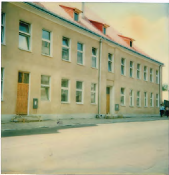
widok budynku MBP od strony ul. Polskiej.
