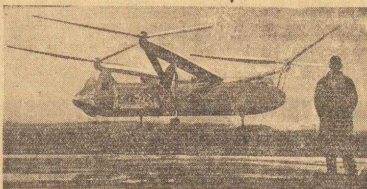
„Latający koń” nazwano wyprodukowany ostatnio w Anglii helikopter pasażerski według projektu słynnego konstruktora włoskiego La Cierwa. Złotokopier zabiera może na pokład 21 pasażerów i dwie osoby załogi lotniczej. Dysponuje on trzema rotarami, uprzątniętymi w ruch przez zwykły motor lotniczy. „Latający koń” może wiać na pokład ładunek wagi trzech ton.
