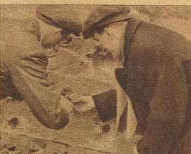
Godz. 9.30. Robotnicy zakładają lonty, które zapalą trotyl, tkwiący w wywierconych w betonie otworach
