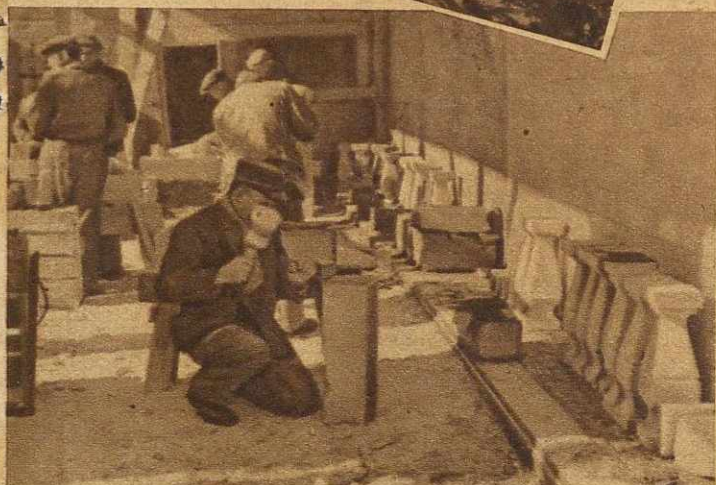
Prace na trasie W-Z prowadzone są w niesłabnącym tempie. Obecnie trwają tam m. in. roboty wykopowe przy budowie ściany oporowej tunelu. Szczyt jej ozdobi balustrada z piaskowca. Na dziedzińcu pałacu Pod Blachą kamieniarze wykonują jej filarki
