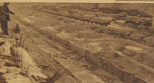
Godz. 9.40. Lonty połączono przewodami z baterią elektryczną, umieszczoną w Al. Jerozolimskich przy bldwej stacji PKS-u
