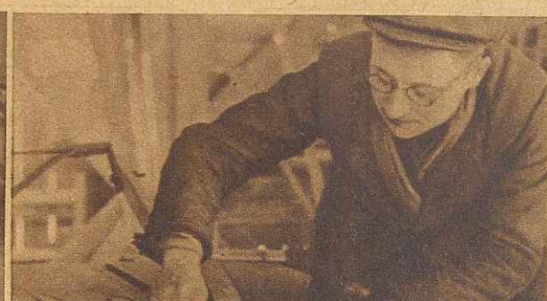
Stolarz-wynalazca, zatrudniony przy budowie Domu PZPR, Zacharzewski skonstruował pomysły przyrząd do piły, pozwalający na szybką zmianę wymiaru ciętych desek, potrzebnych do szalowań
