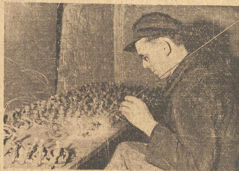
Sparawca fabryki H. Cegielski w Poznaniu, Czesław Michalek, dzieki swemu pomyslowi wykonal w grudniu 23.000 kompletnych obracek do wagonow, zuzywajac 60 butli tlenu. Dawniej, 6 spawaczy wykonywalo miesciennie 25.000 kompletnych przy zuzywaniu 230 butli tlenu. Michalek wchodzi w sklad delegacji polskiej na Swiatowy Kongres Pokoju w Paryżu.
