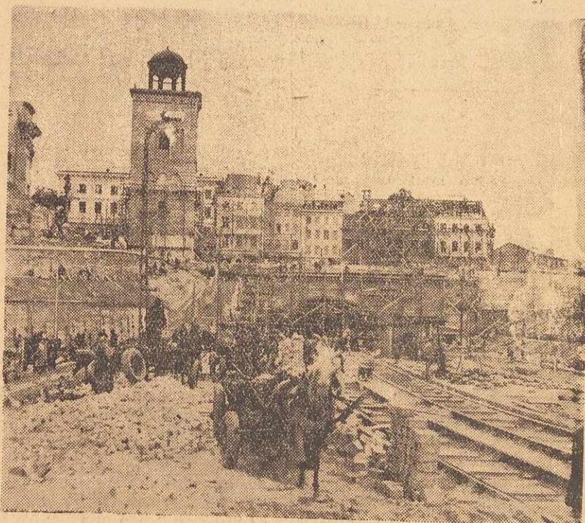
Wjazd do tunelu z dnia na dzień p. rzuca coraz efektywniejszy wygląd. Na Plac Zamkowy wieść będą wyg. schody (na lewo). Zabytkowe kamieniczki, stojące na płycie tunelu, pokrywane są dachówką.
