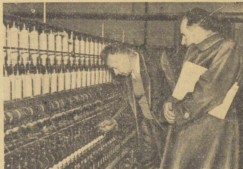
Na zdjęciu: Inżynier radziecki Siergiej Fokin i naczelny inżynier Adam Niezrecki sprawdzają nowo zmontowaną samoprzężnicę obróbkową w Piotrkowskim Kombinate.
