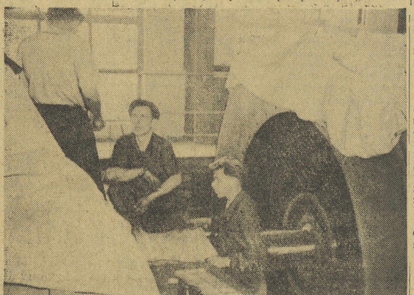
Brygada Piotra Owczarka kończy już montaż generatora, turbiny i innych części u sercu „Żerania”. Właśnie stąd, z tego niepozornego na pierwszy rzut oka urządzenia, popłynie elektryczna energia.
